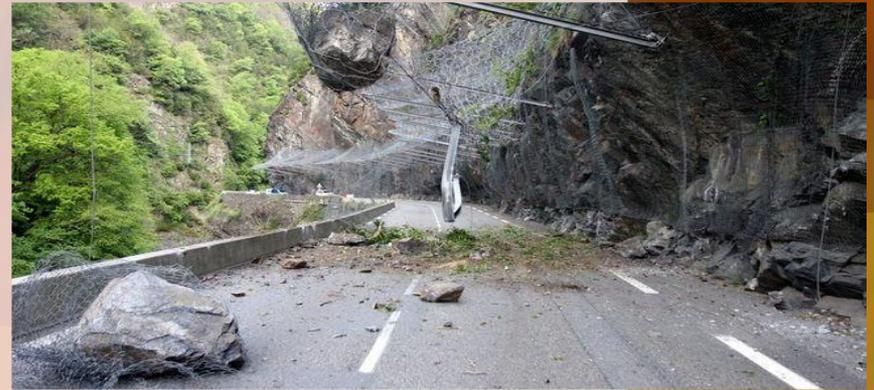
Peu de mesures existent pour prévenir contre des chutes d'ampleur. Des filets installés peuvent bloquer les petits gravats, les plus gros rochers ne peuvent être arrêtés.
