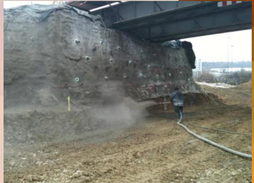
*Principe du clouage et exemple de réalisation*
